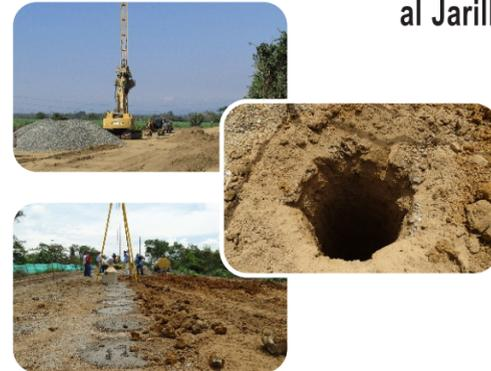
En la obra de reforzamiento del Jarillón del Canal Interceptor Sur, se han alcanzado ya, 1.300 metros lineales de la construcción de la pantalla de suelo cemento de 9 metros de profundidad, creada para evitar que la hormiga arriera traspase el jarillón y que las filtraciones de agua por niveles altos del Canal Interceptor o el río Cauca, lleguen a colapsarlo.
